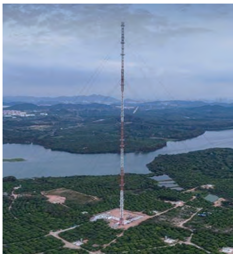
图1 深圳气象观测梯度塔
